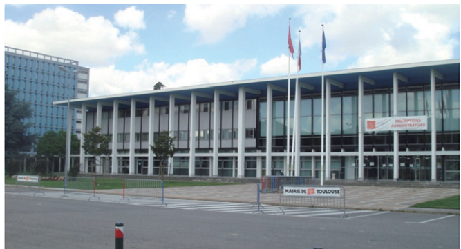
René Egger, Bâtiment de l'administration et du grand amphithéâtre
